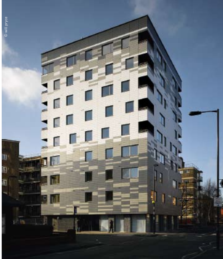
La façade du Stadthaus est protégée par 5 000 panneaux Eternit® en fibres-ciment de 1 200 x 230 mm, composés à 70 % de déchets de bois.
