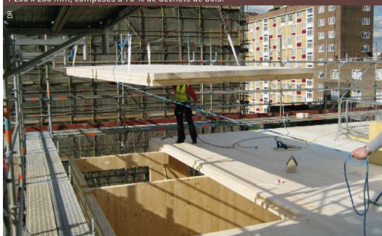
Livrés sur le site de construction, les panneaux en bois massif contrecollé KLH sont immédiatement positionnés à leur place définitive, offrant un appréciable gain de temps.
