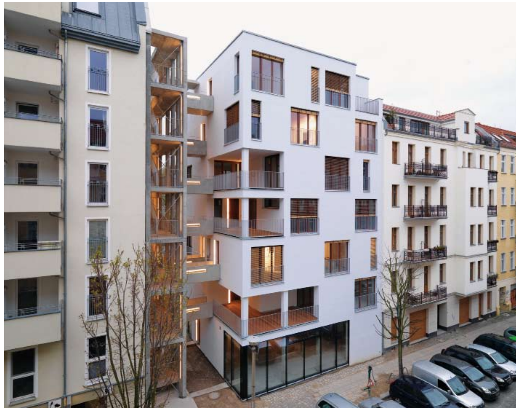
Dès l'origine, le maître d'ouvrage a insisté sur la nécessaire flexibilité des logements. D'où la position excentrée de l'escalier et de l'ascenseur.
