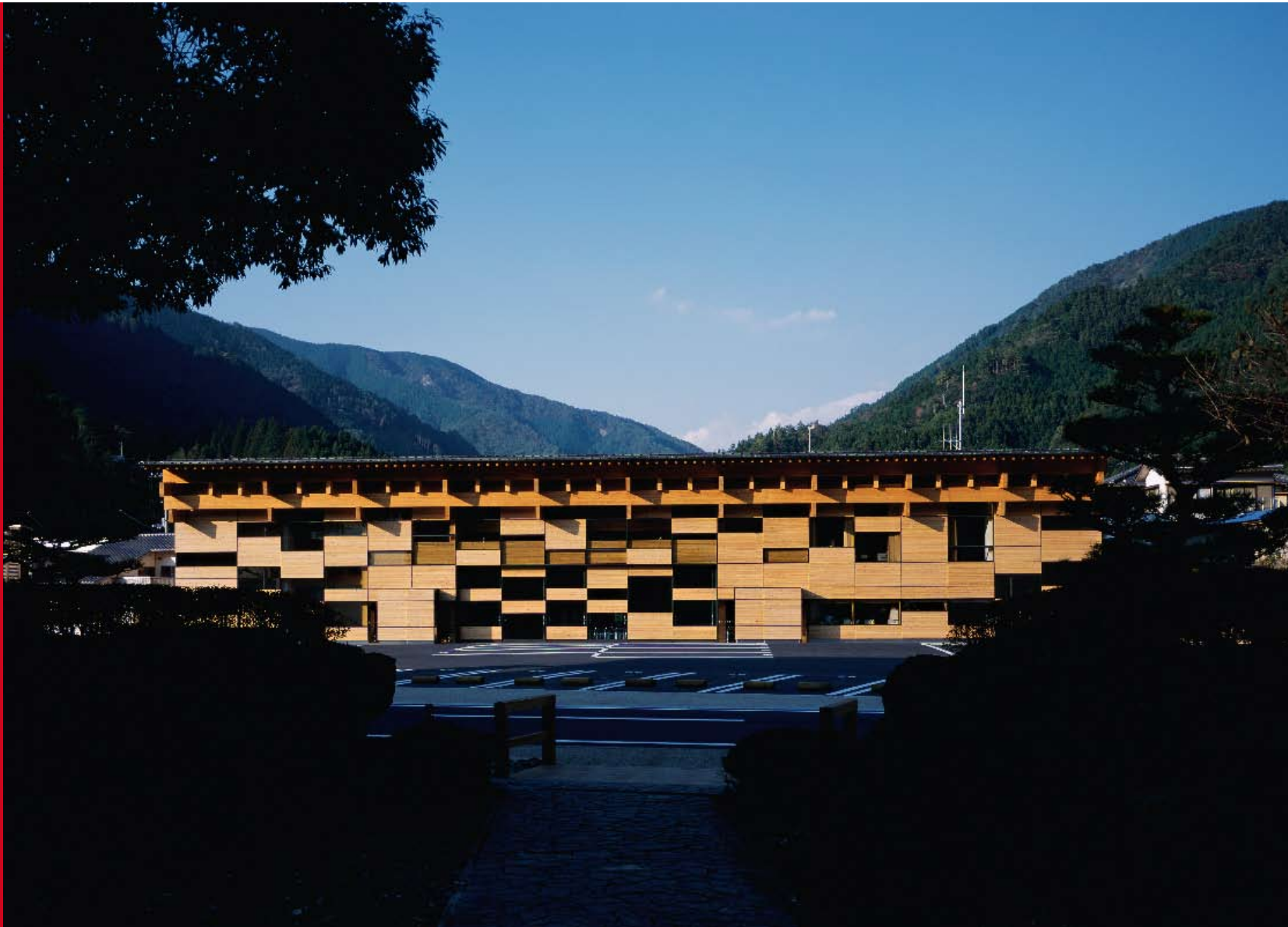
La façade sud comprend une série de panneaux de cèdre alternant irrégulièrement avec des panneaux transparents. Ce motif en damier est fonction de l'orientation et donne un caractère tridimensionnel à la façade. / The south façade has a series of cedar panels alternating in an irregular fashion with transparent panels. This draughtboard pattern depends on the orientation and gives a three-dimensional character to the façade.
