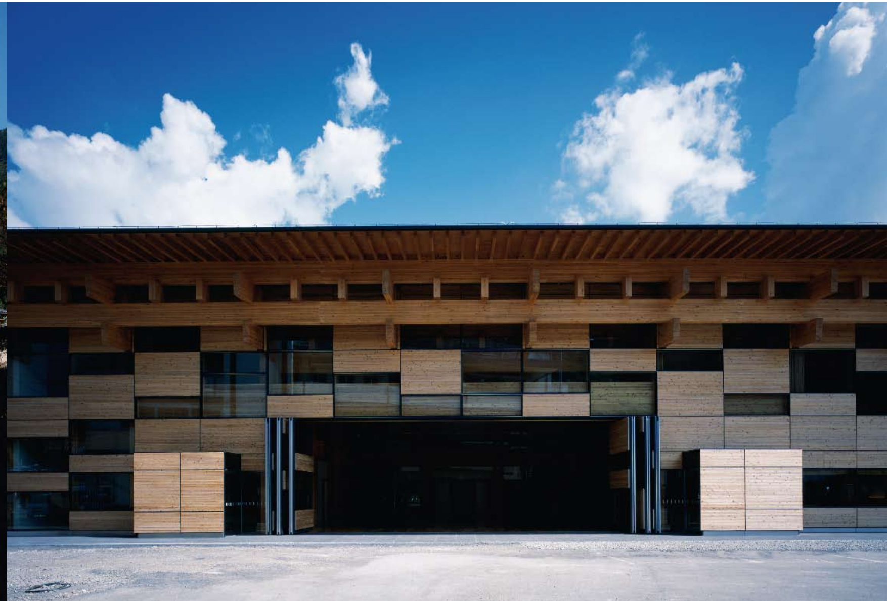
L'accès s'effectue par deux boîtes saillantes placées de chaque côté d'une immense porte coulissante, dont l'ouverture pendant les mois chauds et humides assure une ventilation naturelle au bâtiment. / One enters via two striking boxes placed on either side of an immense sliding door which is opened during the warm humid months, ventilating the building naturally.
