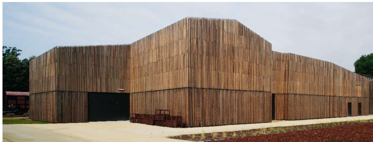
La résille brise-soleil, les sheds et les panneaux de résille pivotants participent à la régulation thermique de l'écomusée, dans une région aux fortes chaleurs. / The latticed sun screen (fixed or pivoting) and the sheds contribute to the eco-museum's thermo-regulation in this region where temperatures can be very high.
