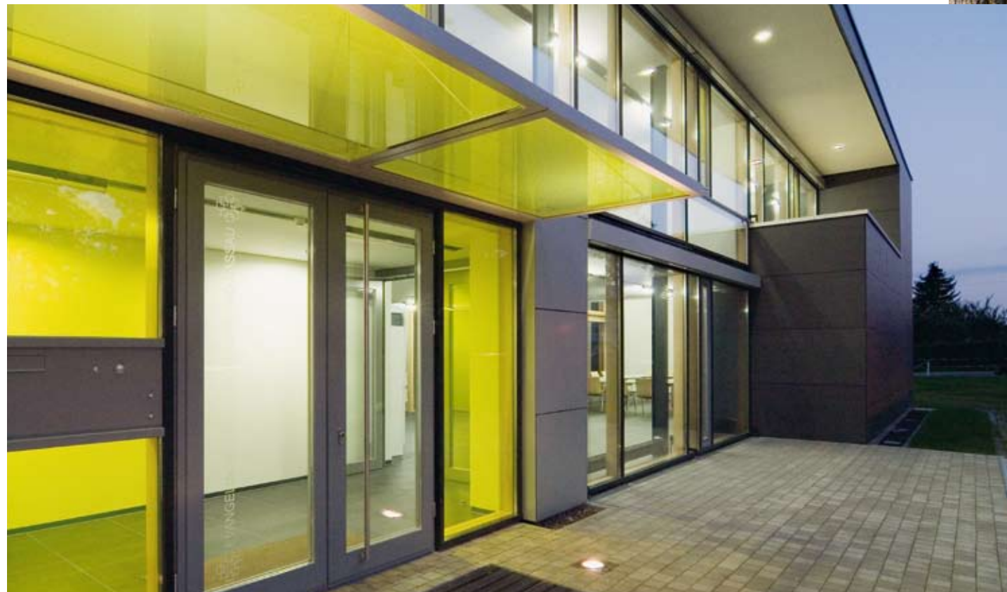
Les portes et les fenêtres bénéficient d'un triple vitrage à isolation renforcée sur les façades est et ouest, côté rue et côté jardin. Tout au long de la journée, le bâtiment profite ainsi d'importants apports solaires. / On the east and west façades facing the road and garden sides, the doors and windows benefit from triple glazing with reinforced insulation. Throughout the day, the building therefore profits from considerable solar heating.
