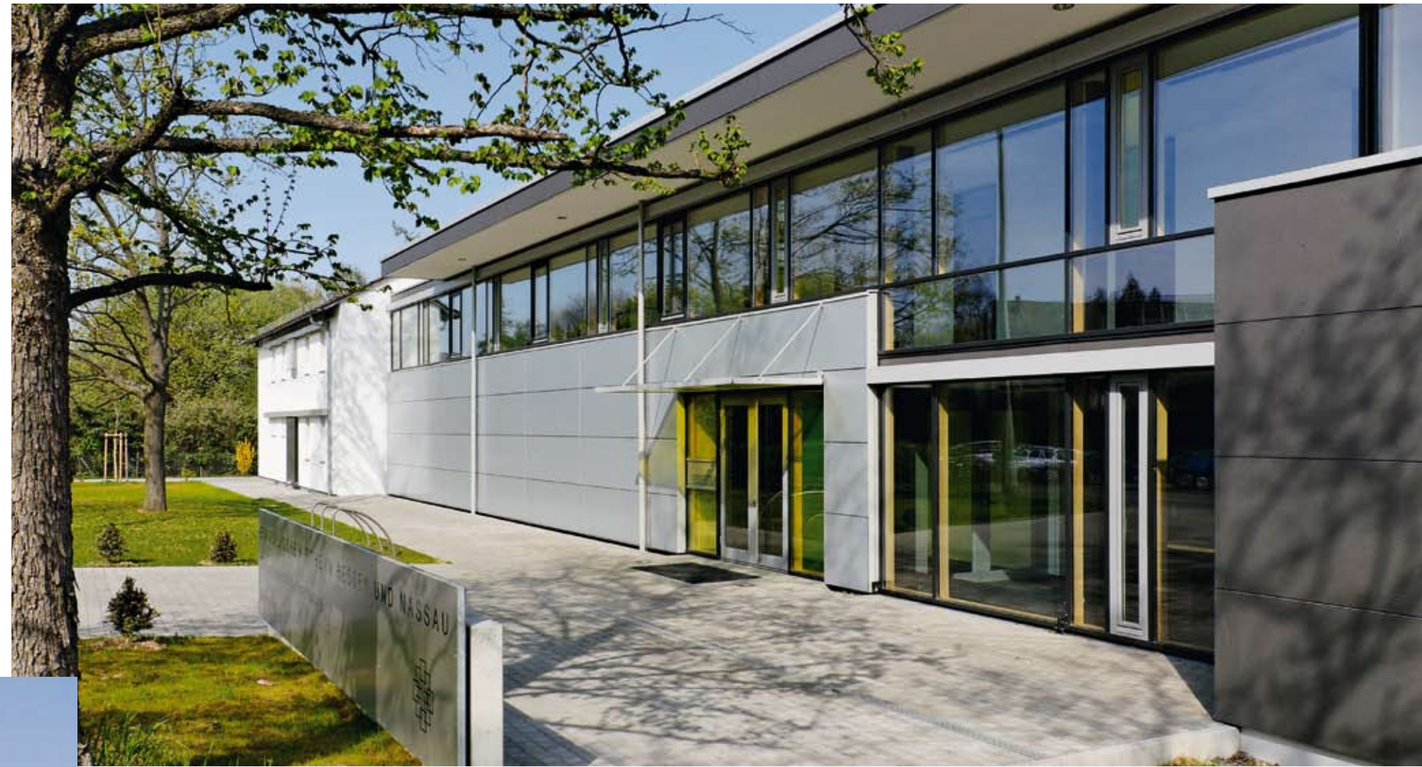
Les parties opaques de l'enveloppe sont isolées avec de la ouate de cellulose issue du recyclage du papier. Les panneaux de façade, en aluminium, participent au contreventement. The opaque sections of the building envelope are insulated with cellulose fibre from recycled paper, while the aluminium façade panels contribute to the wind bracing.
