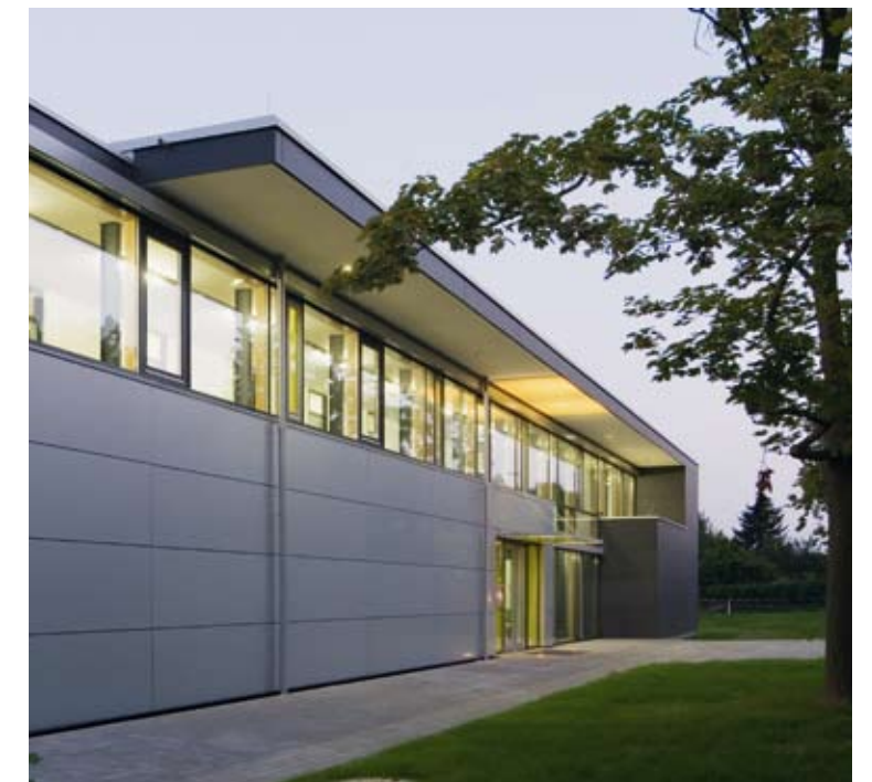
Les parties opaques de l'enveloppe sont isolées avec de la ouate de cellulose issue du recyclage du papier. Les panneaux de façade, en aluminium, participent au contreventement. The opaque sections of the building envelope are insulated with cellulose fibre from recycled paper, while the aluminium façade panels contribute to the wind bracing.
